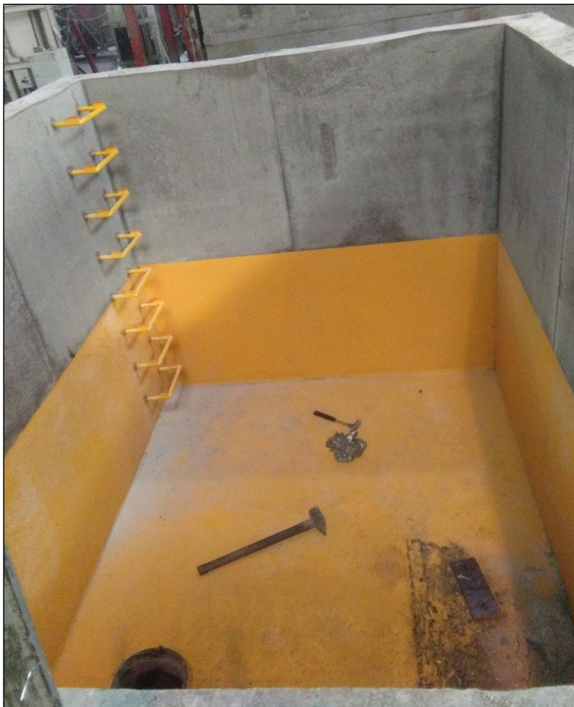
Widok na wykładzinę PEHD w komorze na wysokość 1m
