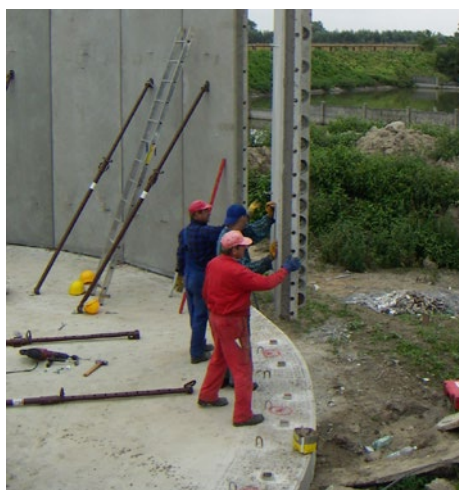
Montaż ścian
