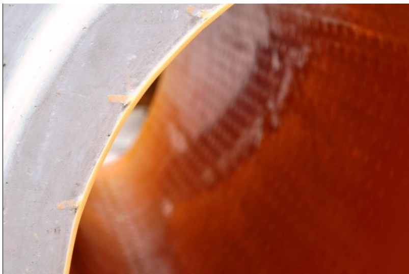
Zdjęcie 3: widok na połączenie wykładziny PEHD ze ścianą rury
