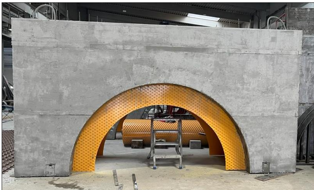
Zdjęcie 9: widok na element gotowy z zamontowaną wykładziną, etap po betonowaniu
