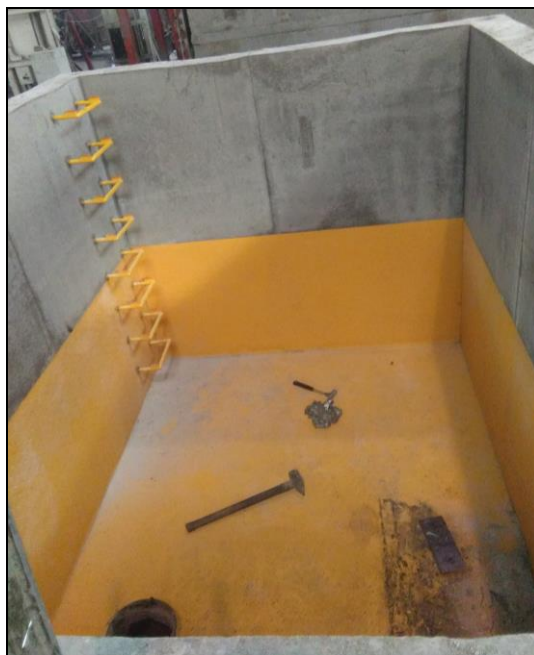
Zdjęcie 5: widok na wewnątrz komory prefabrykowanej, z wykładziną PEHD w dnie i na ścianach do wysokości 1m
