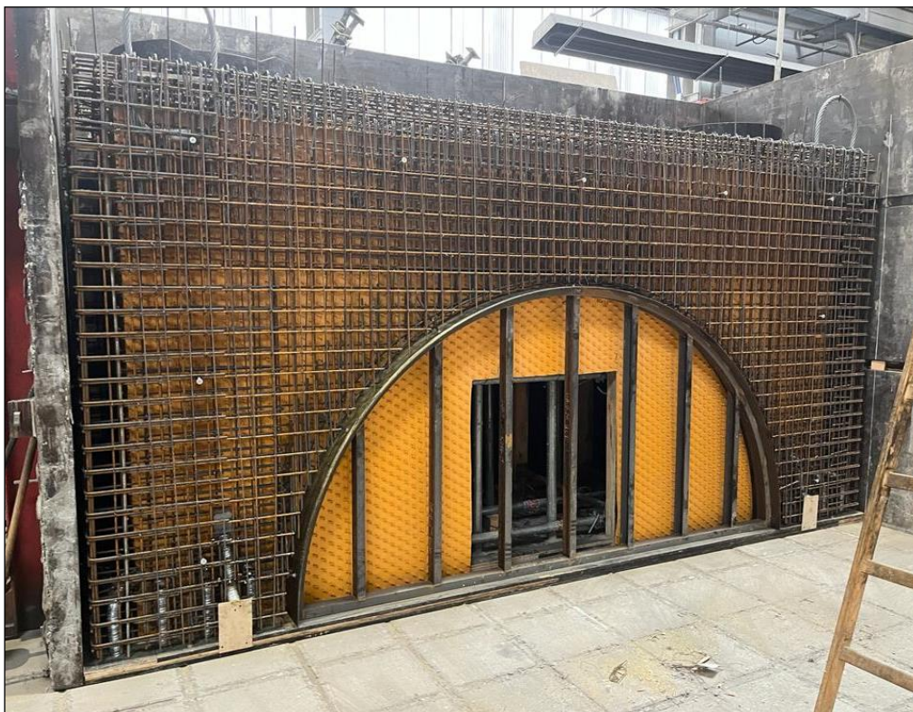
Zdjęcie 8: widok na element zbrojony z zamontowaną wykładziną, etap przed betonowaniem
