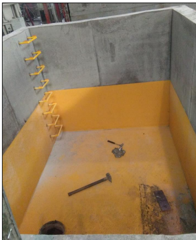
Zdjęcie 4: widok na wewnątrz gotowego wyrobu budowlanego na bazie komory, z wykładziną w dnie i na ścianach do wysokości 1m
